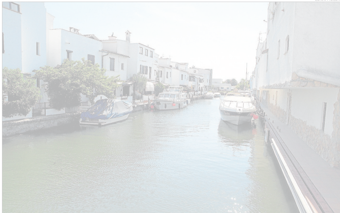
Els canals d'Empuriabrava, on l'atermenament afecta els amarradors i part dels habitatges.
